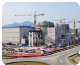
中国岭澳3号和4号机组施工现场
